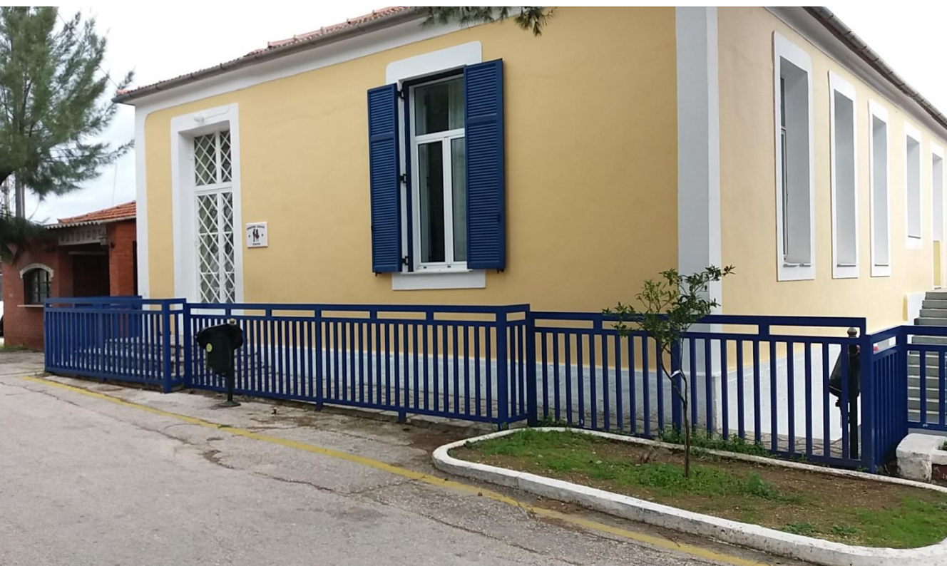
Φωτογραφία 1: Θέση κατασκευής ράμπας ΑΜΕΑ στο Δ.Σ. Σταυρού Ιθάκης
