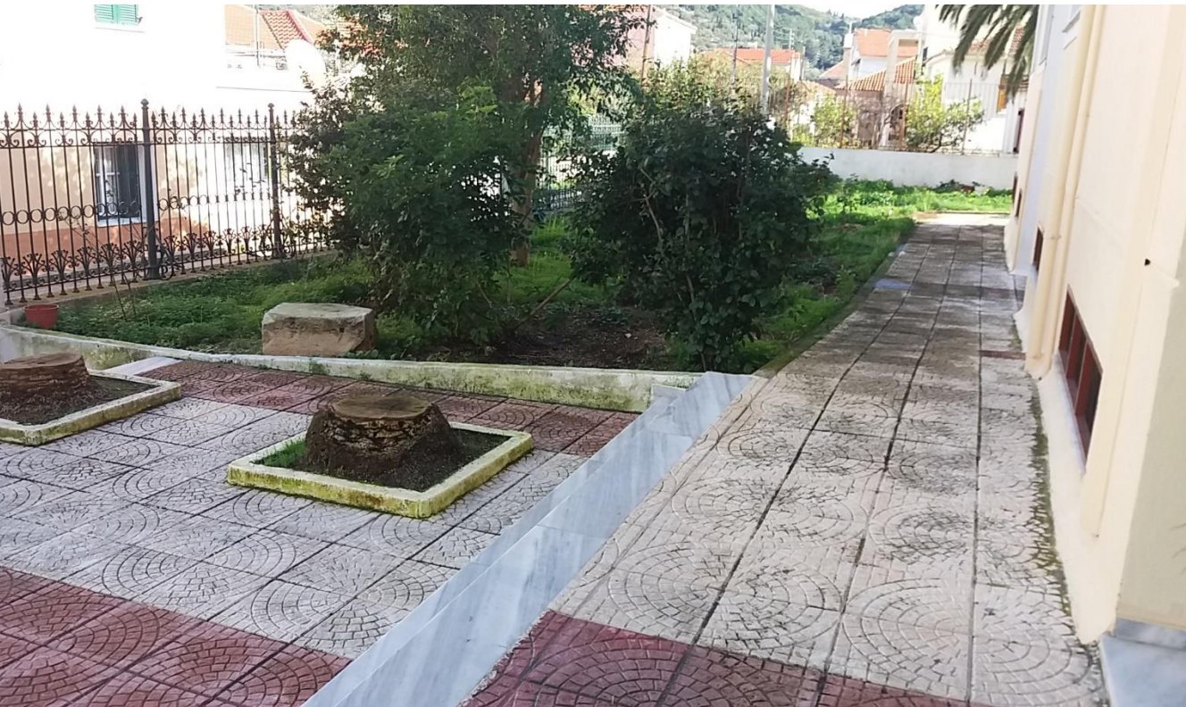
Φωτογραφία 1: Θέση κατασκευής ράμπας ΑΜΕΑ στο Δ.Σ. Βαθέως Ιθάκης
