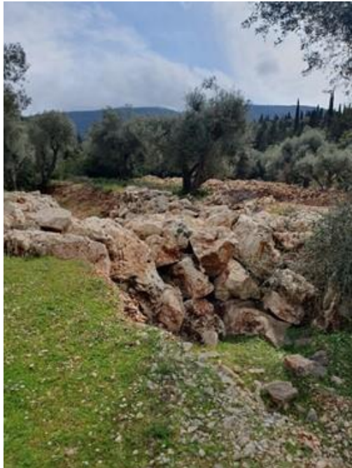
Φωτογραφίες υφιστάμενης λεκάνης ανάσχεσης από λιθορριπή
