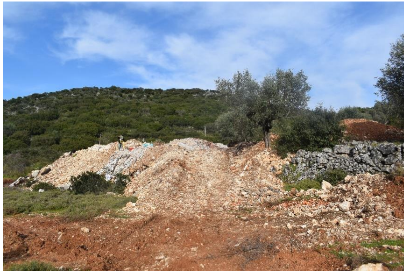
Φωτογραφίες θέσης κατασκευής προτεινόμενων νέων φραγμάτων
