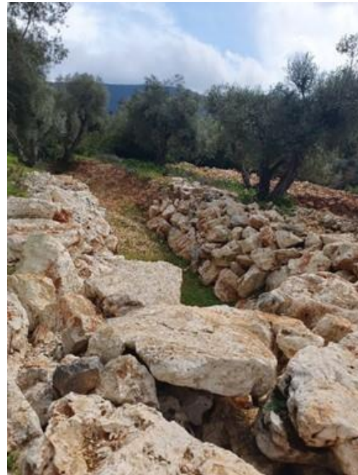
Φωτογραφίες υφιστάμενης λεκάνης ανάσχεσης από λιθορριπή
