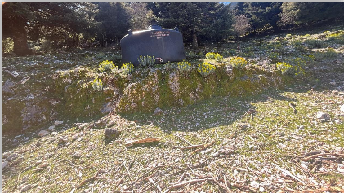
Εικόνα 71: Πολυεστερική υδατοδεξαμενή κλειστού τύπου χωρητικότητας 25 κυβικών εντός του Εθνικού Δρυμού σε υψόμετρο 800μ.
