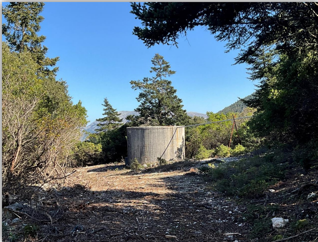
Εικόνα 78: Εγκατεστημένη τσιμεντένια υδατοδεξαμενή χωρητικότητας 100 κυβικών μέτρων, στη θέση Ομπρέλλα, σε υψόμετρο 710μ.
