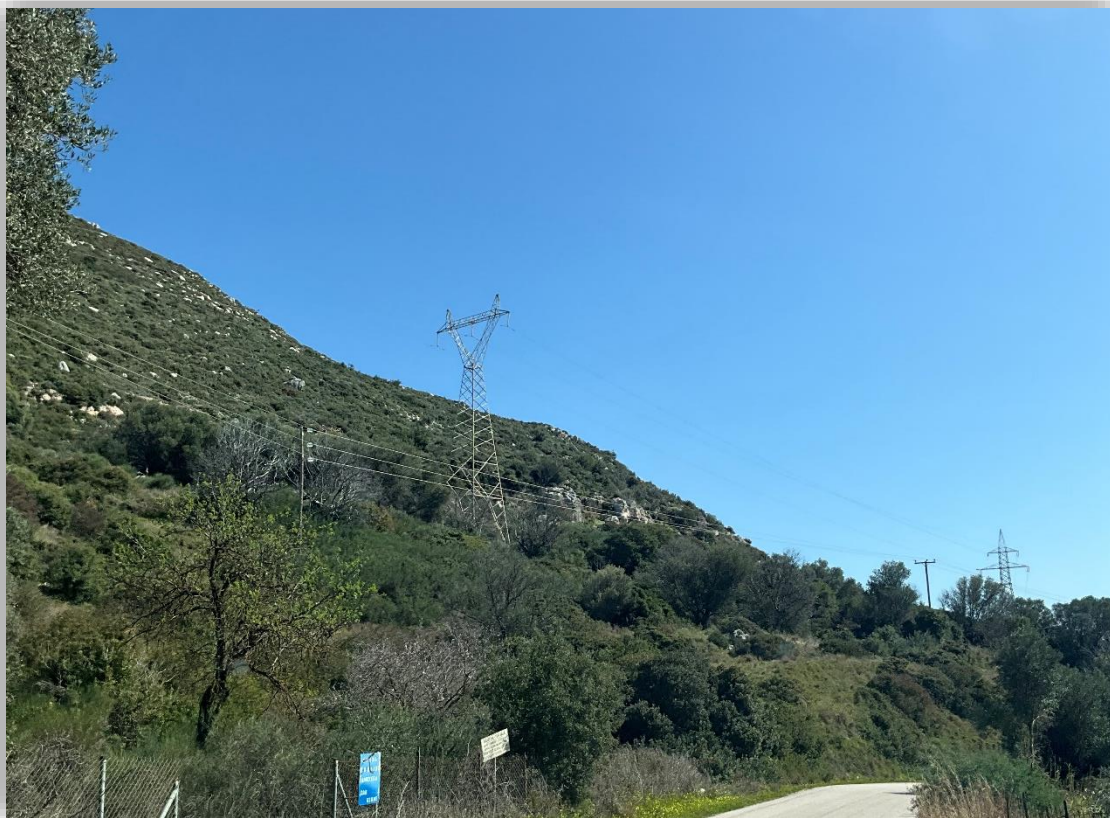
Εικόνα 66: Διερχόμενες γραμμές μέσης και υψηλής τάσης που υπέρκειται σε υψηλής πυκνότητας βλάστησης δενδρώδους και θαμνώδους μορφής
