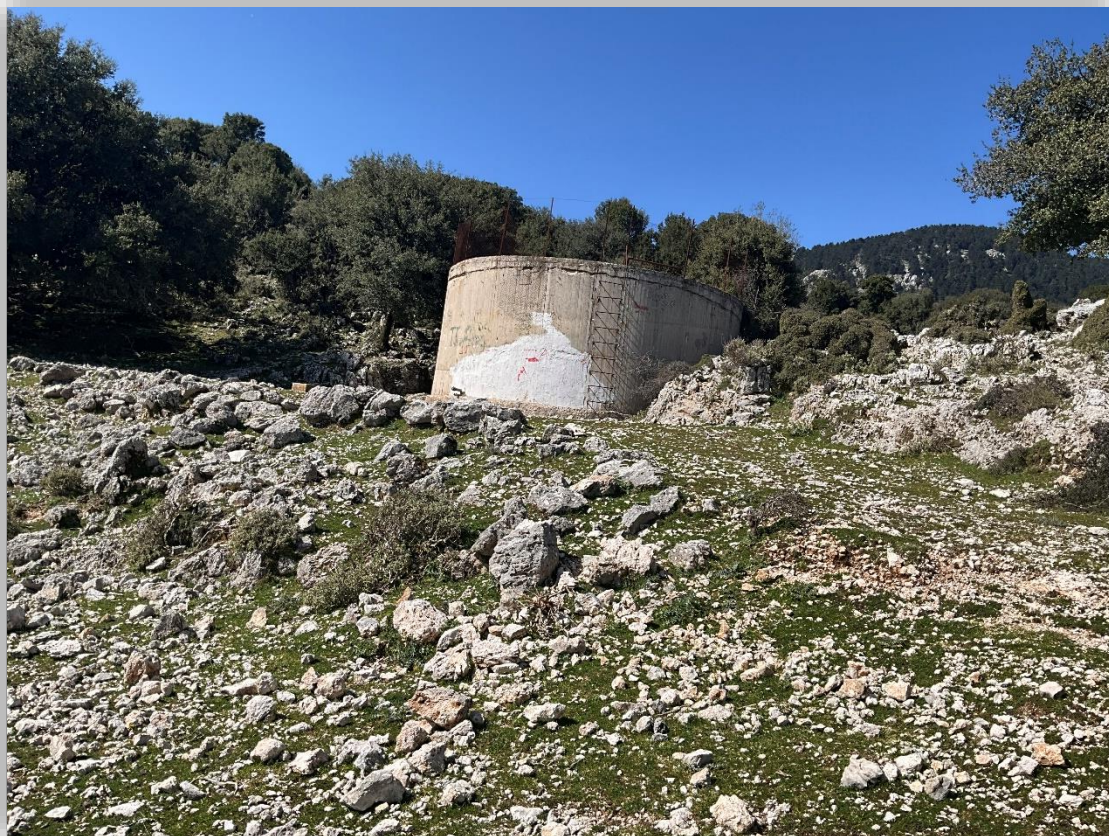
Εικόνα 65: Τσιμεντένια υδατοδεξαμενή κλειστού τύπου που χωροθετείται πλησίον του οικισμού Αργίνια.
