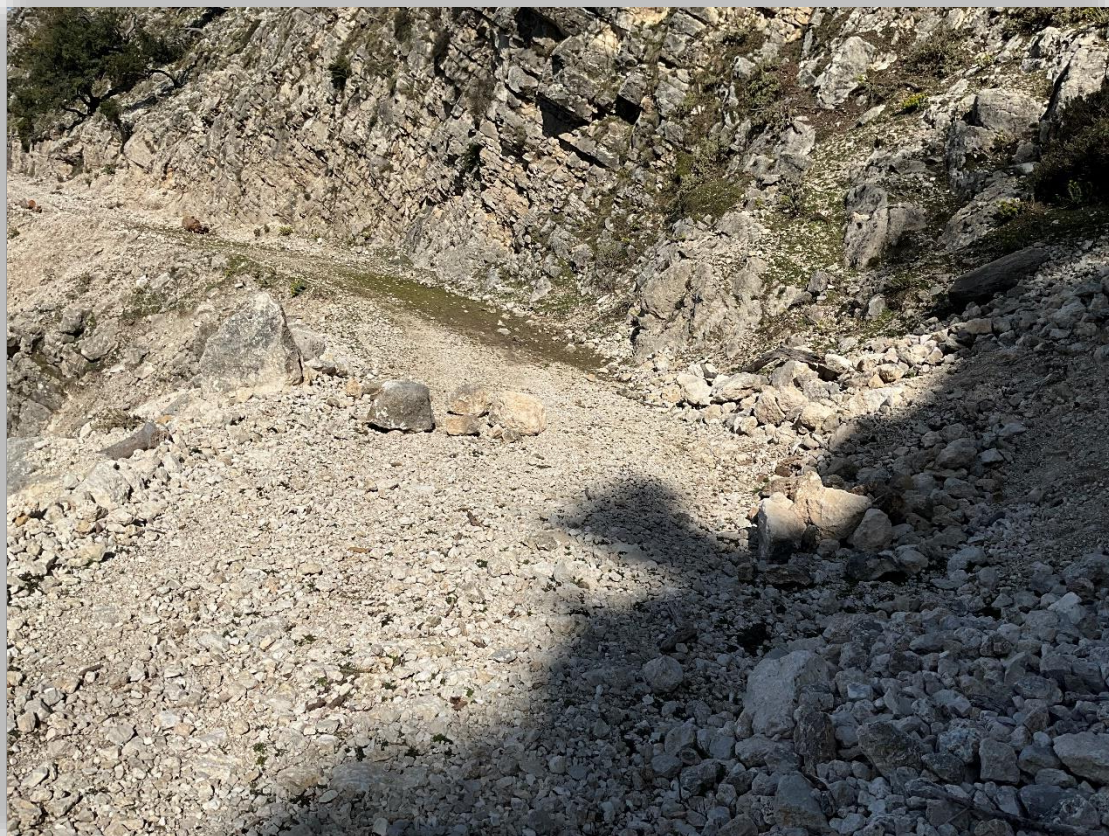
Εικόνα 63: Απροσπέλαστο σημείο στο οδικό δίκτυο του Εθνικού Δρυμού του Αίνου λόγω κατολίσθησης.
