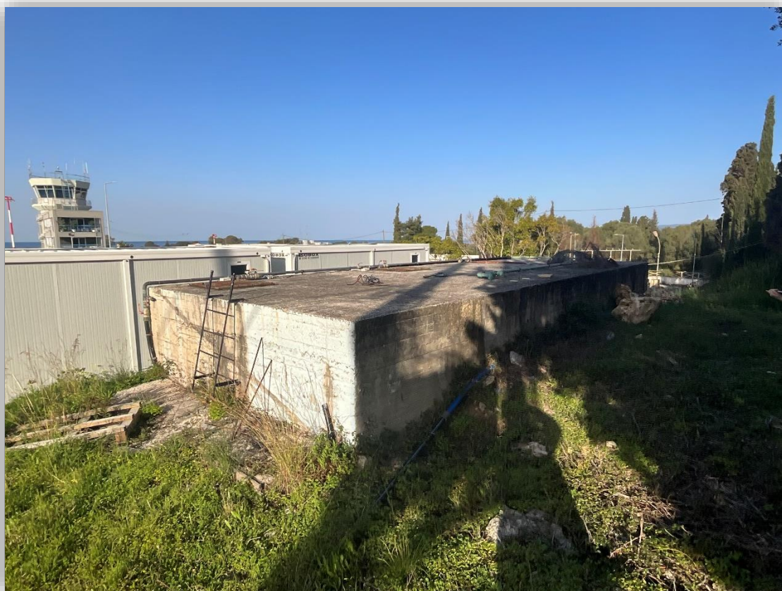
Εικόνα 60: Τσιμεντένια υδατοδεξαμενή κλειστού τύπου, στην περιοχή του αεροδρομίου.
