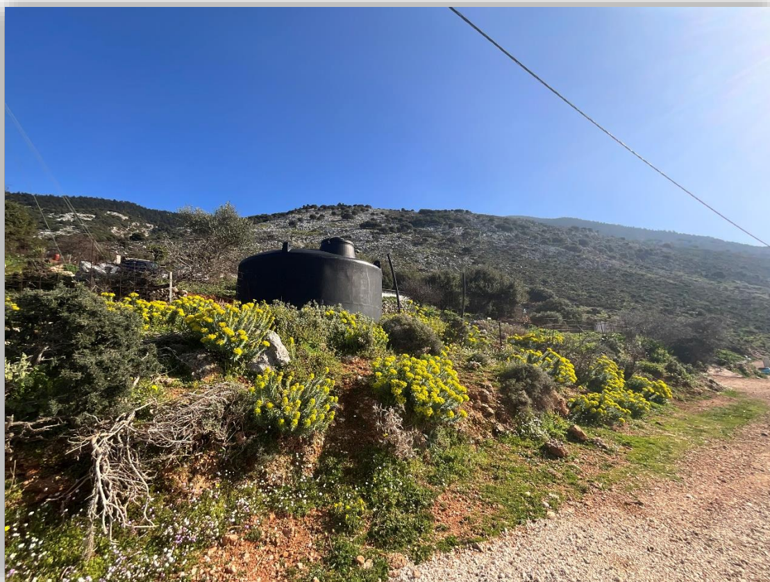
Εικόνα 62: Υδατοδεξαμενή πολυεστερική, χωρητικότητας 25 κυβικών στους πρόποδες του Αίνου.
