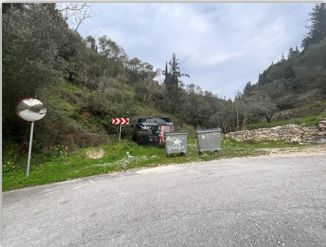
Εικόνα 92: Πολυεστερική υδατοδεξαμενή κλειστού τύπου στην περιοχή του οικισμού Εξωγή.
