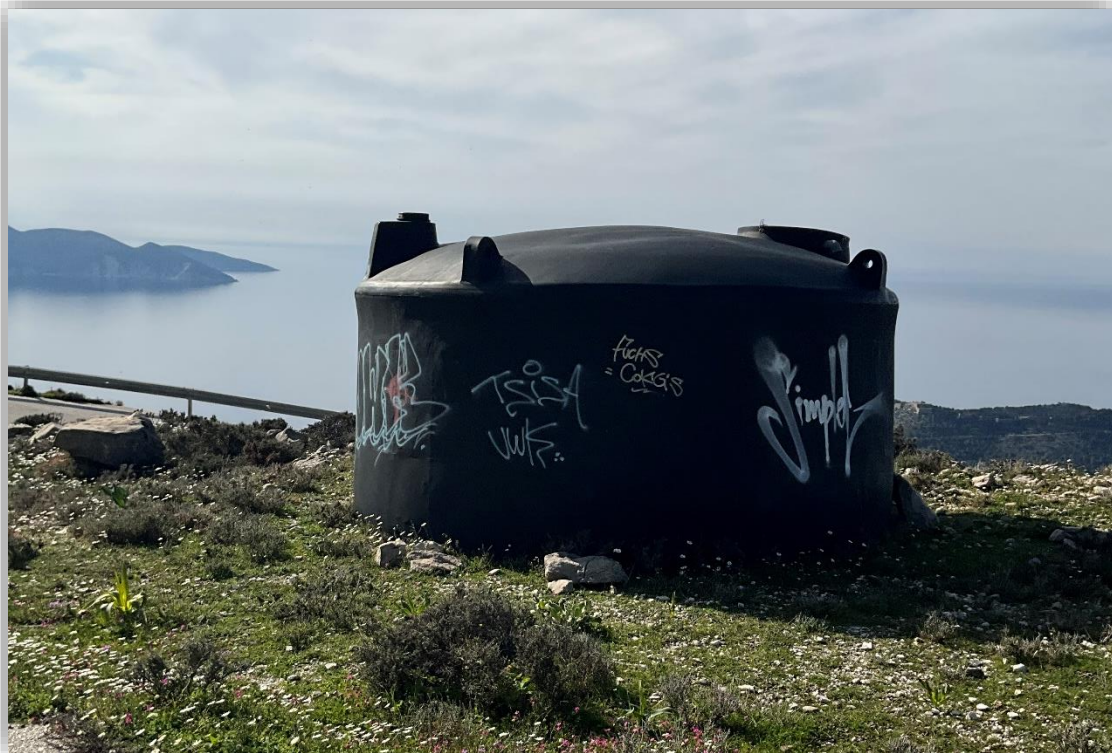
Εικόνα 81: Πολυεστερική υδατοδεξαμενή χωρητικότητας 25 κυβικών μέτρων στο βορειοανατολικό τμήμα του νησιού σε υψόμετρο 460 μ.
