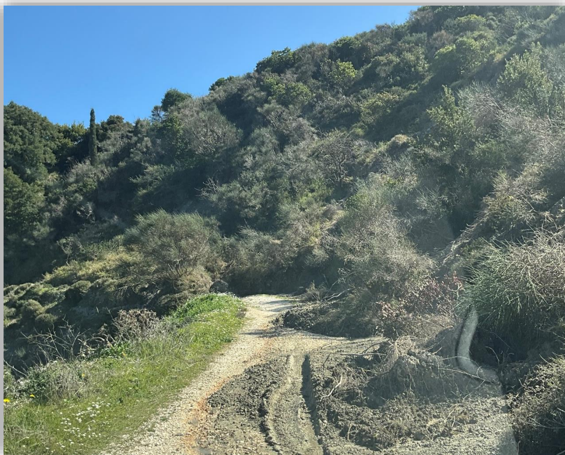
Εικόνα 67: Απροσπέλαστο σημείο του οδικού δικτύου λόγω της πρόσφατης πλημμύρας στην ευρύτερη περιοχή.
