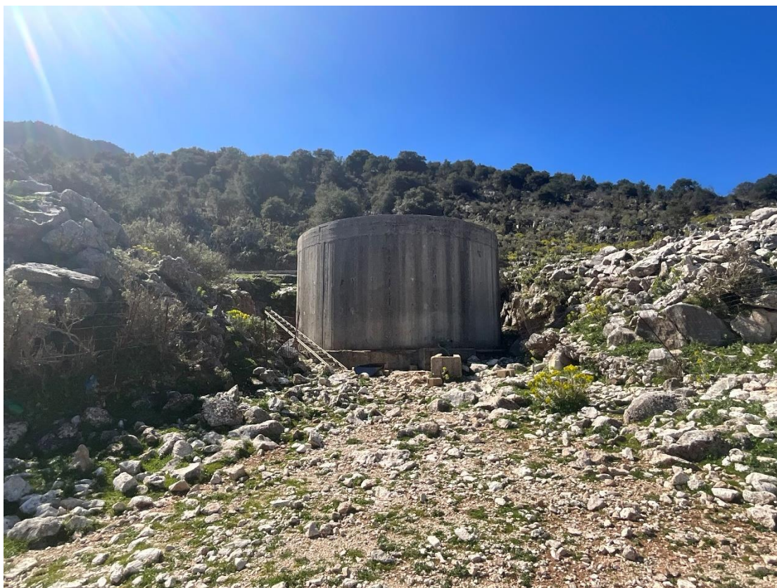
Εικόνα 69: Τσιμεντένια υδατοδεξαμενή χωρητικότητας 200 κυβικών, στους πρόποδες του Εθνικού Δρυμού.
